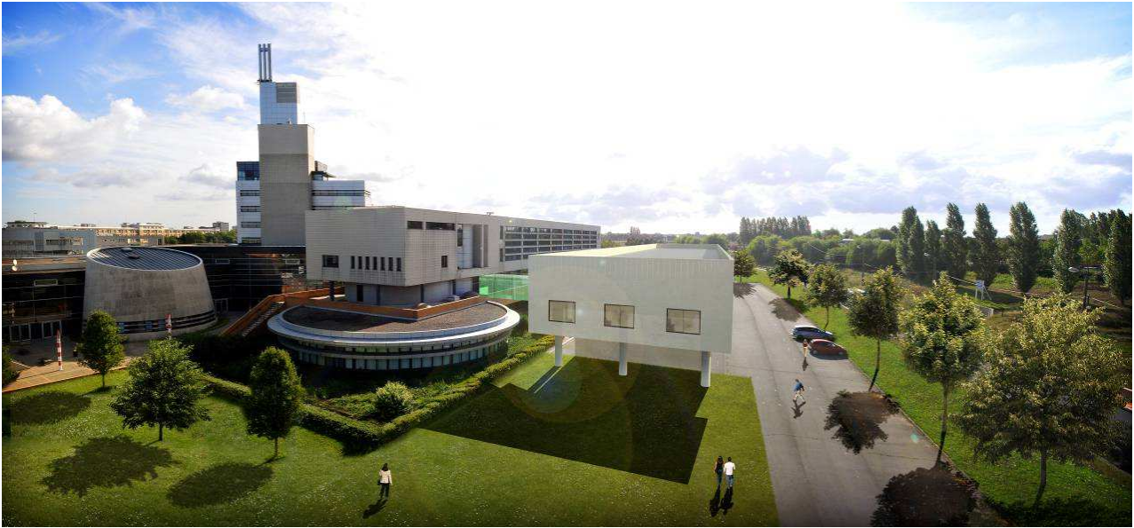
Extension du pôle Formation Santé – Site Santé Campus Lille
