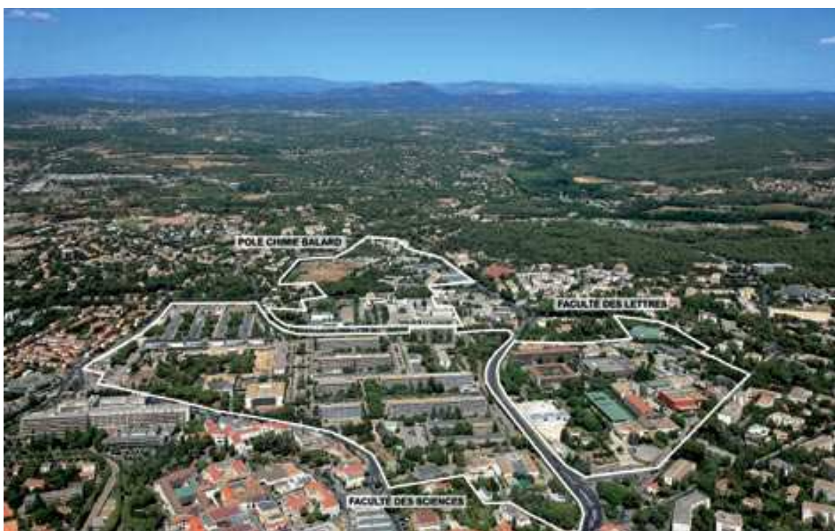
Vue du coeur de campus : faculté des sciences, faculté des lettres et pôle chimie
