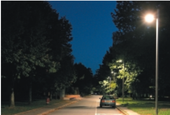
Éclairage de la voie centrale.
